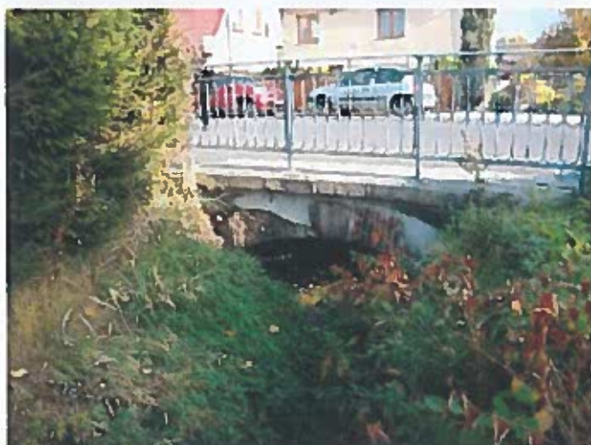
Levá strana mostu
