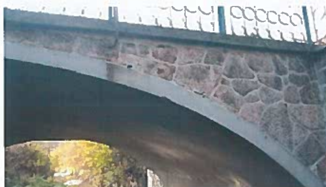
Uložený roh v čele klenby
