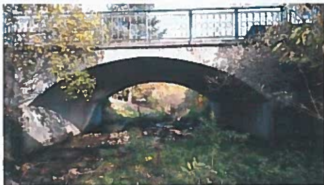
Levá strana mostu
