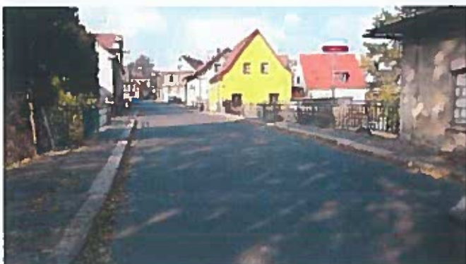
Pohled po směru staničení
