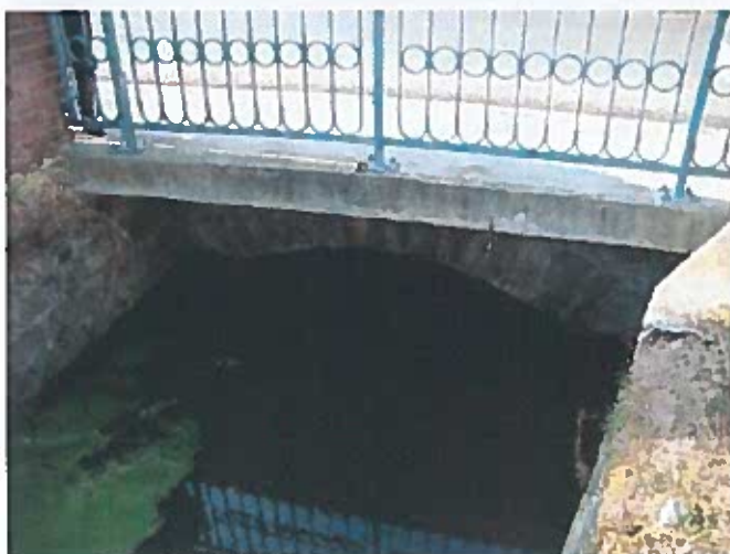
Pravá strana mostu
