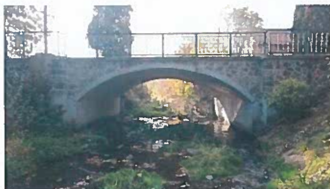
Pravá strana mostu
